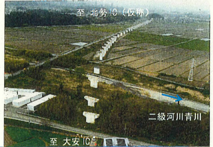
②東海環状自動車道（いなべ市大安町地内）
