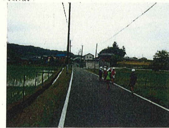
歩道がなく路肩も狭小であり、通学児童等が危険な状態
