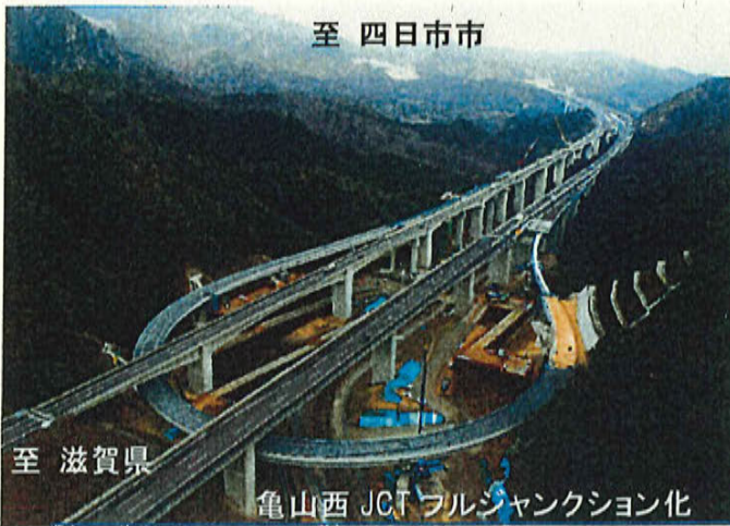
①新名神高速道路（亀山市安坂山町地内）
