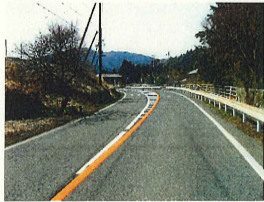
車両通行の安全確保を図るため、区画線の引き直しを実施
