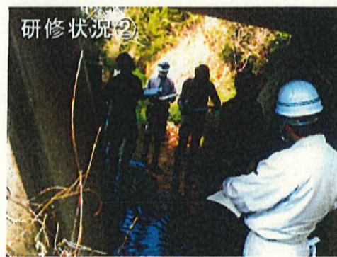
桁下より橋台、床版等を点検
