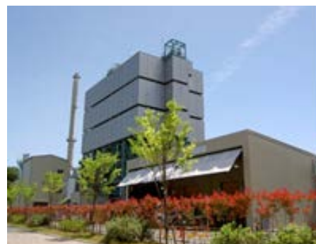
RDF焼却・発電施設
