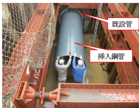
PIP工法による既設管への鋼管挿入状況 (内径1000mm P C管布設替)
