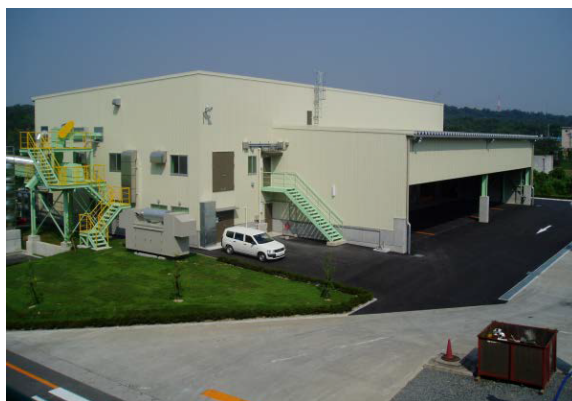
RDF貯蔵施設
