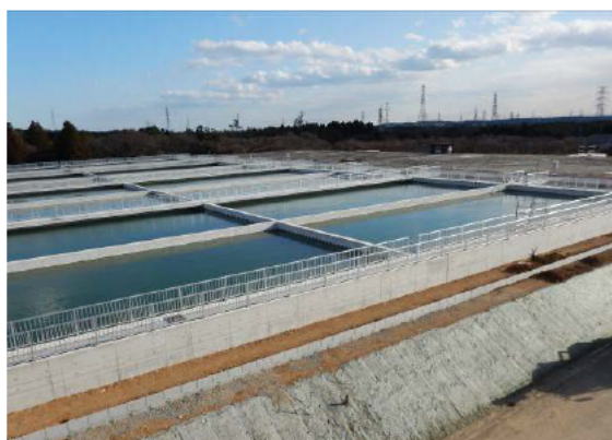
耐震補強工事が完了した沢地浄水場 (平成27年度完了)
