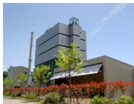
RDF焼却・発電施設
