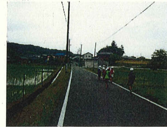
歩道がなく路肩も狭小であり、通学児童等が危険な状態
