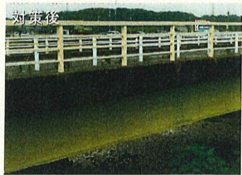
高欄、主桁の塗替えと高欄の部分補修を実施
