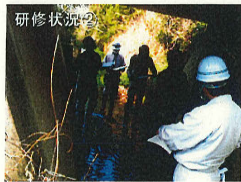
桁下より橋台、床版等を点検
