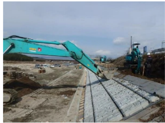
一級河川 木津川 (伊賀市)
