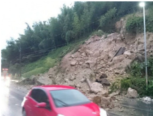
一般国道 421 号 被災状況
