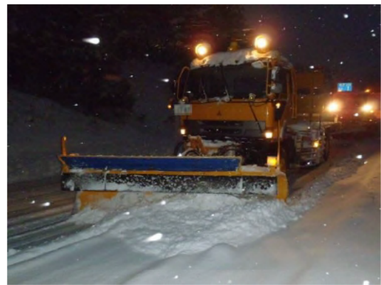
道路の除雪作業 (いなべ市)
