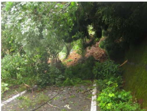
一般国道 169 号 被災状況
