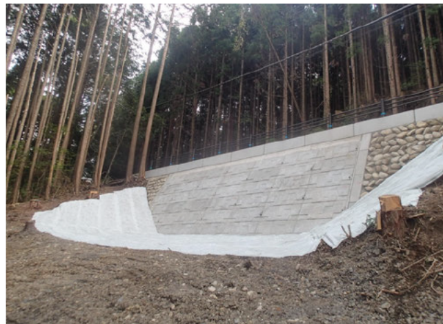
復旧した大型ブロック積工を望む
