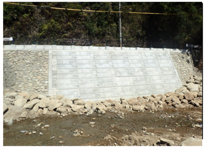
相野谷川から工事箇所を望む
