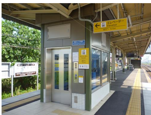
鉄道駅に設置されている エレベーター（伊勢若松駅）
