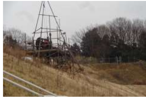
掘削状況 (H30.2.1撮影)
