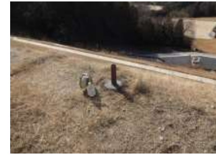
設置状況 (H30.2.27撮影)
