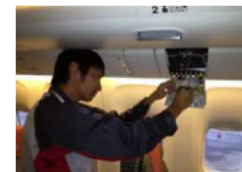
客室内の照明の交換
