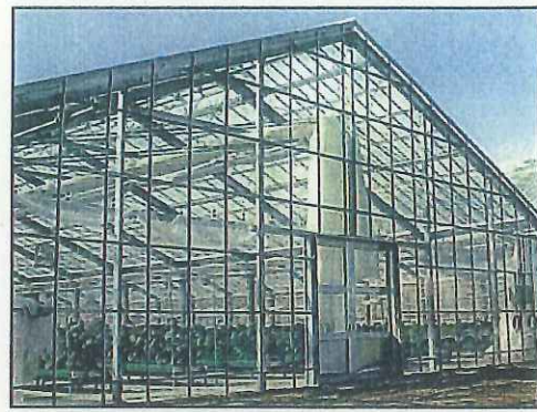
両屋根型鉄骨ハウス
