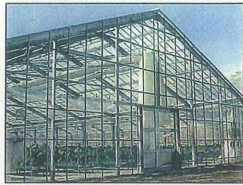
両屋根型鉄骨ハウス
