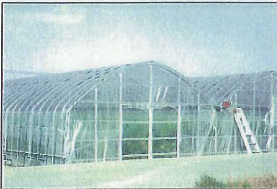
パイプハウス（被害が大きかった）
