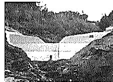
治山ダムの整備
