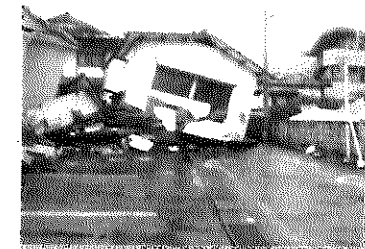
倒壊して道路をふさぐ建築物(熊本地震)
