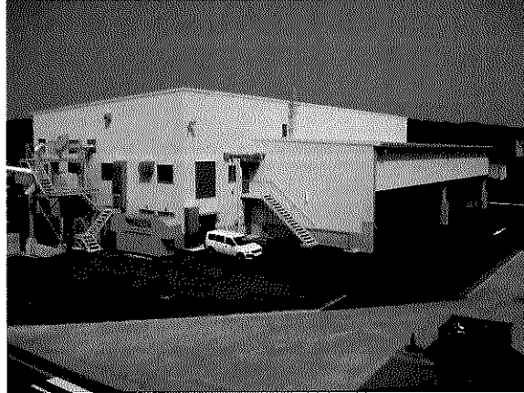
RDF貯蔵施設
