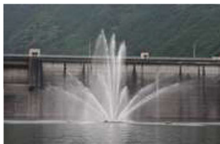
図 3.2-1 蓮ダムの表層曝気循環装置(噴水) 出典:中部地方整備局蓮ダム管理所 Web ページ
