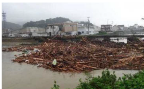
図 3.4-3 2011年9月紀伊半島大水害 橋梁に押し寄せた流木(熊野市) 出典:「災害に強い森林づくり」の評価のためのガイドライン(三重県、2016年3月)
