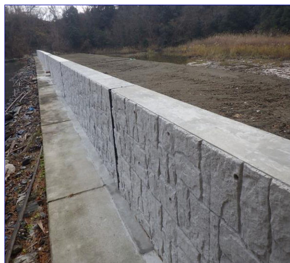
復旧後の農地海岸堤防（塩竈市寒風沢島）
