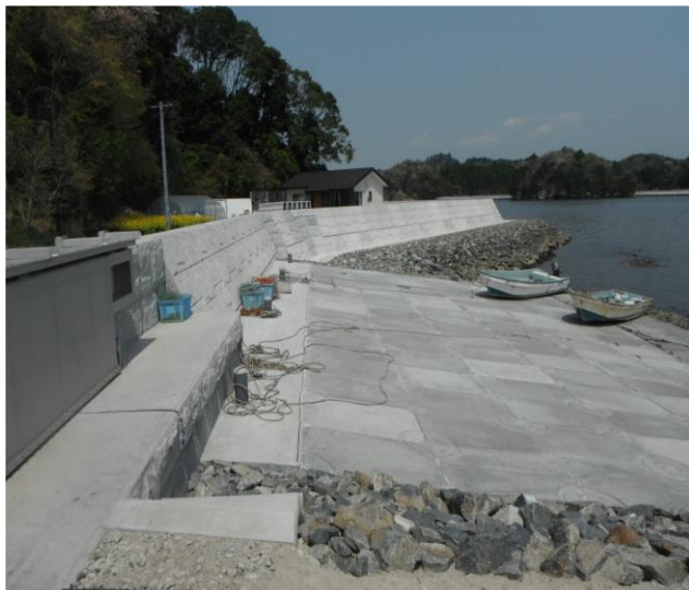
復旧後の農地海岸堤防（松島町）
