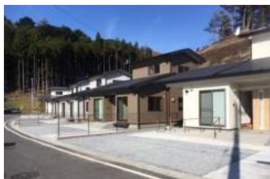
横浦地区災害公営住宅
