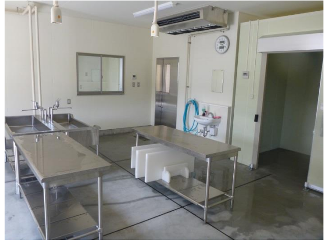
写真2：水産物加工施設内部
