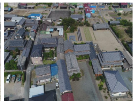
ドローンによる被害状況偵察
