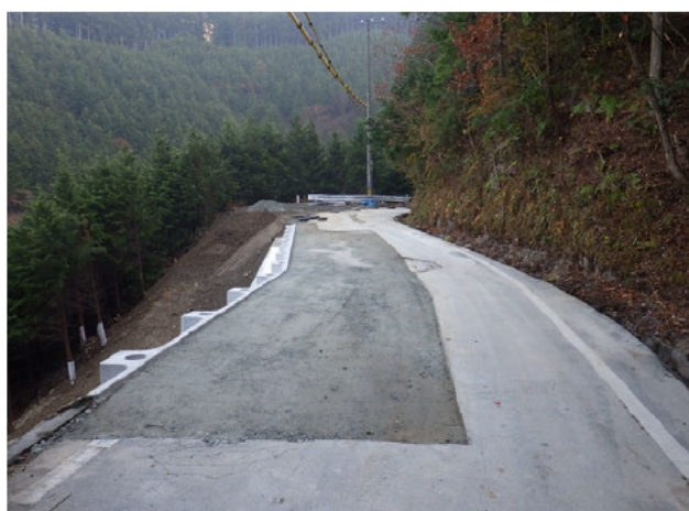
復旧状況 平成30年12月20日 撮影
