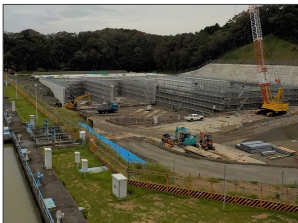
山村浄水場耐震化工事（施工状況）
