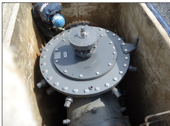
φ 800 制水弁工事（不断水工設置状況）
