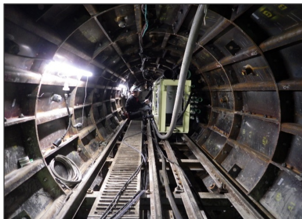
φ 1200 配水管工事（一次覆工状況）
