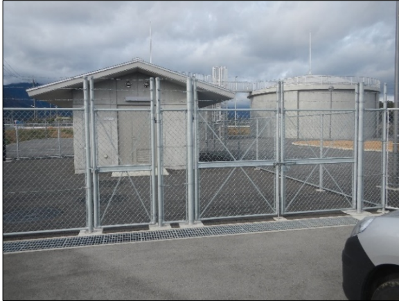
分水施設（分水建屋:左側 市町受水槽:右奥）
