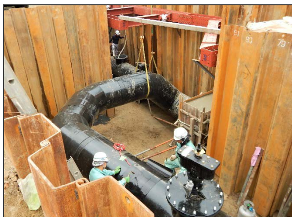
φ 1000 配水管工事（布設状況）
