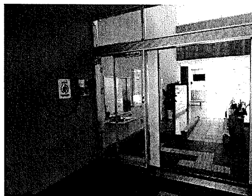
整備基準適合証プレート が設置されている施設 (三重県立松阪あゆみ特別支援学校)
