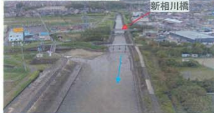
二級河川相川 新相川橋
