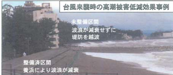
宇治山田港海岸二見地区(二見工区)
