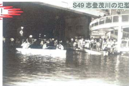
S49 志登茂川の氾濫 国道23号江戸橋付近 (津市)
