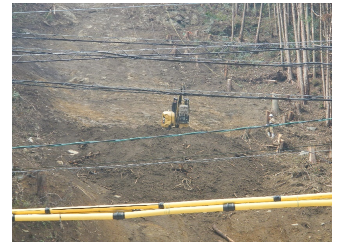
特殊機械による不安定土砂・浮き石等の除去状況
