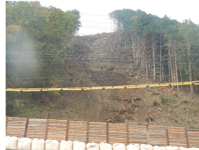
特殊機械による不安定土砂・浮き石等の除去状況
