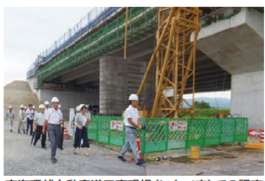
東海環状自動車道工事現場(いなべ市)での調査
