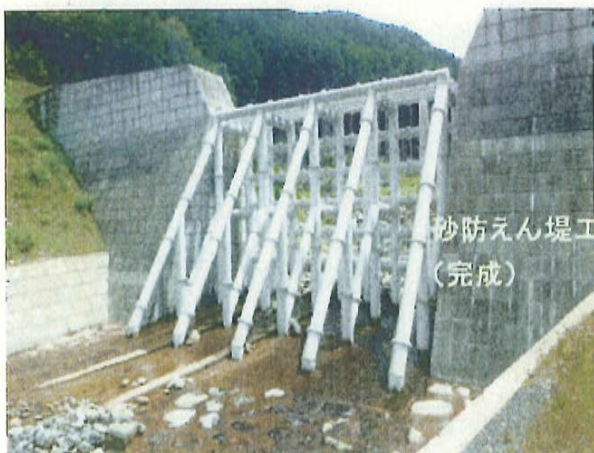
●通常砂防事業（桑谷川：熊野市）
