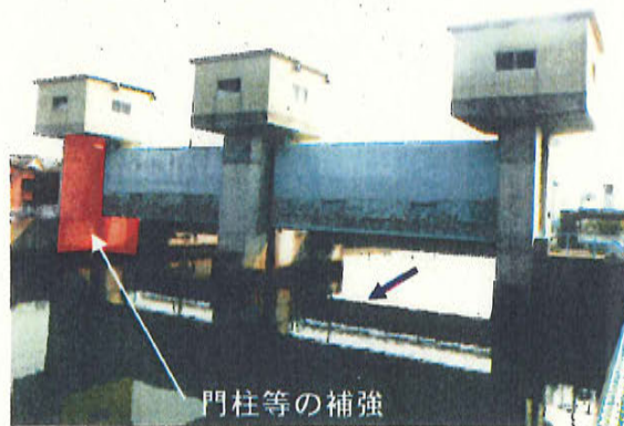
【鶺方水門(前川)】大型水門の耐震対策 （志摩市鶺方）
