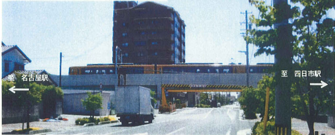
近鉄川原町駅付近連続立体交差事業（四日市市） L=680m（平成28年5月8日高架切替完了）
