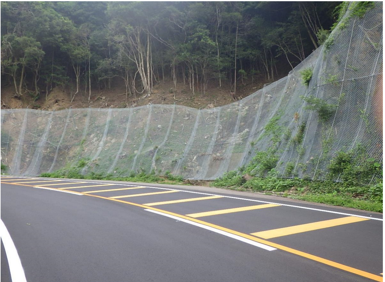
対策完了箇所 (H29.7撮影)
