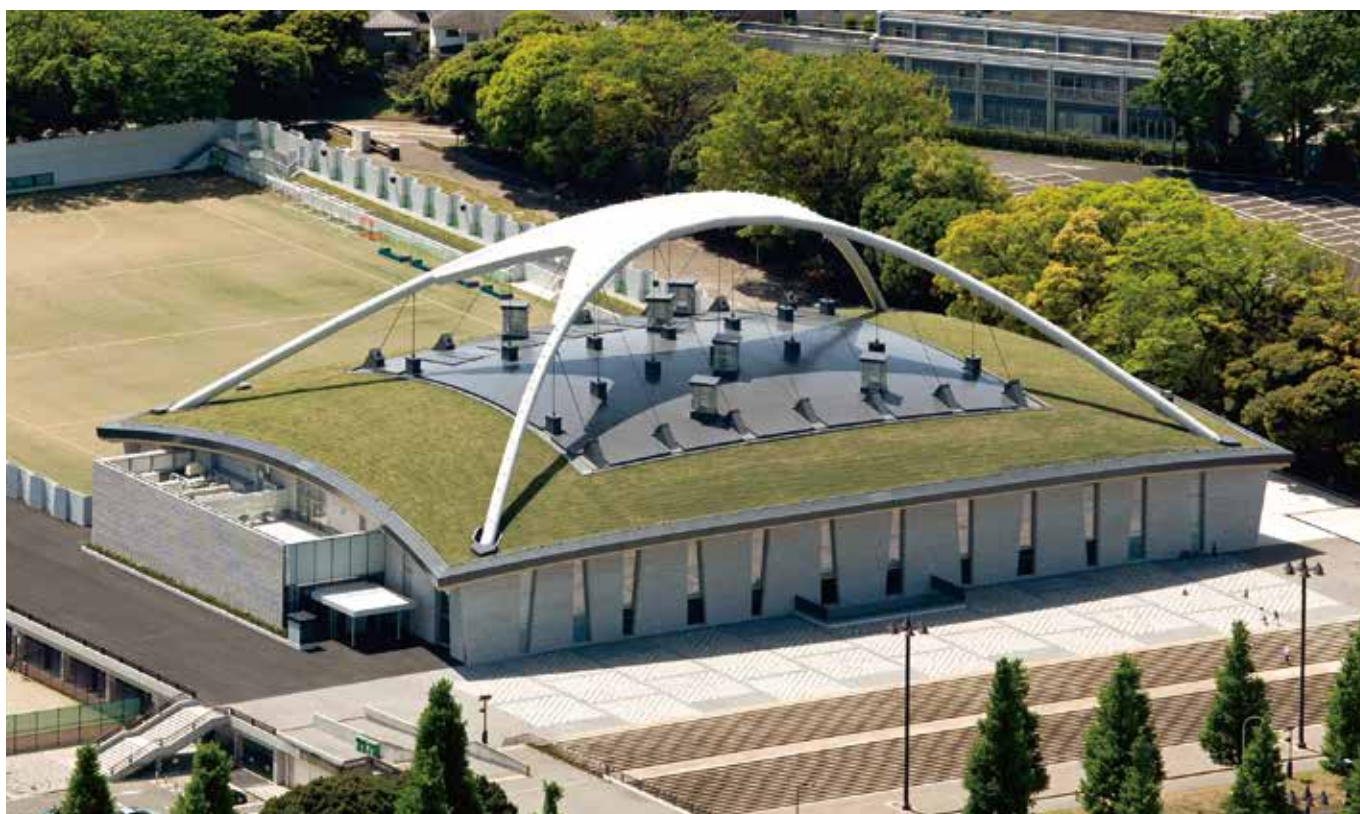
タマリユウを使用した屋内球技場の屋根緑化（駒沢オリンピック公園総合運動場 東京都）
