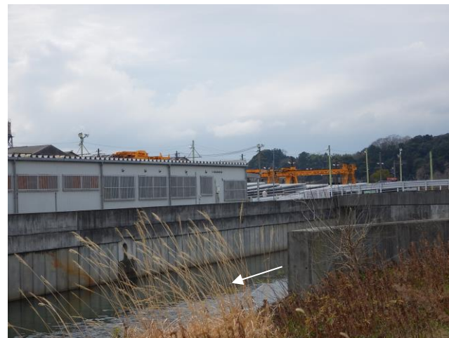
□ 下流部：PC壁体による改修状況
