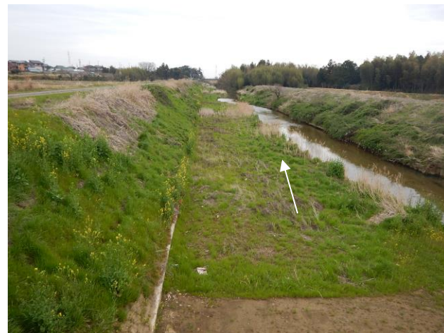
□ 下流部：堤防・護岸の整備済み区間
