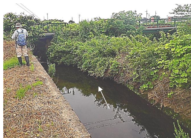
□ 上流部：JR関西本線横過部の状況
