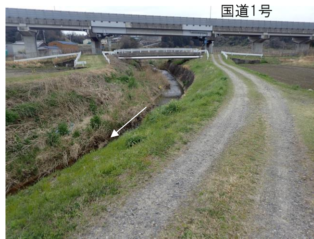
□ 上流部：未改修区間
