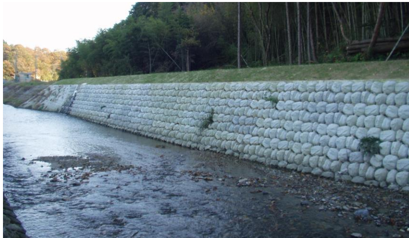
足見川上流部 護岸施工済み区間
