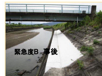
護岸ブロック沈下
