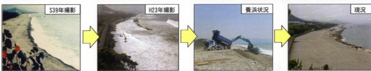
熊野川直轄河川改修事業による掘削土砂を大規模に投入することにより、海浜が安定しています。
