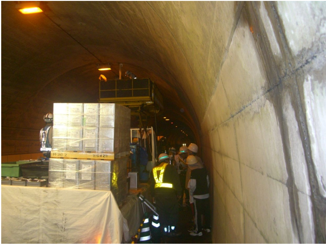
工事中の現場見学
