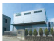
● 建設中の松阪工場
