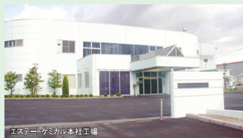
エステートケミカル本社工場
