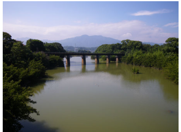
志原川下流部（志原橋より上流）
