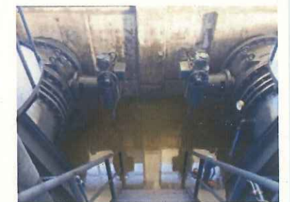
水没のため停止した排水機 (伊勢市)
