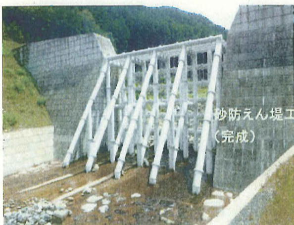
●通常砂防事業（桑谷川：熊野市）
