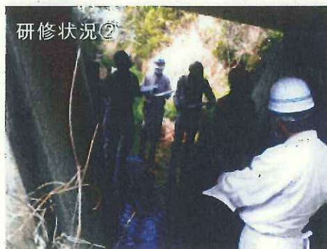
桁下より橋台、床版等を点検
