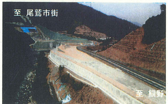
⑥ 熊野尾鷲道路Ⅱ期（尾鷲市南浦地内）
