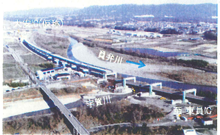
② 東海環状自動車道（いなべ市大安町地内）
