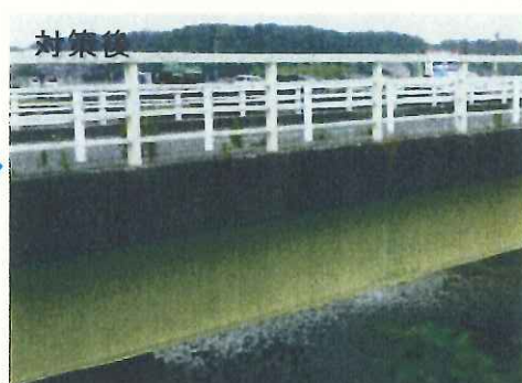
高欄、主桁の塗替えと高欄の部分補修を実施
