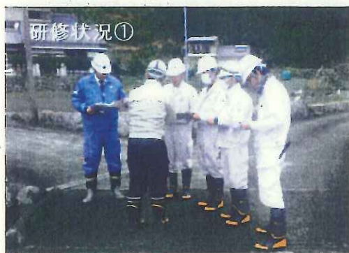
点検前に、点検のポイントについて説明
