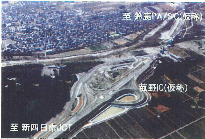
① 新名神高速道路（菰野町音羽地内）
