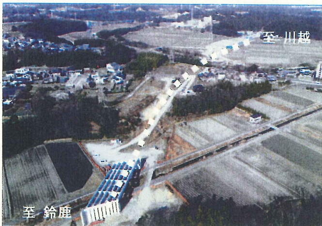
③ 北勢バイパス（四日市市西坂部町地内）
