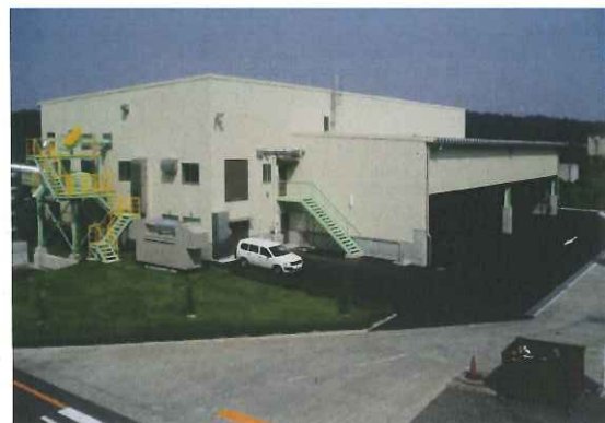
RDF貯蔵施設
