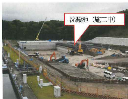
耐震化工事施工中の山村浄水場 (平成32年度完成予定)
