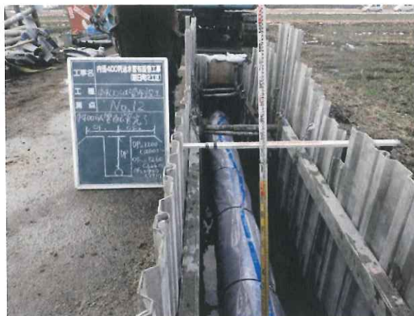
耐震管への布設替え状況
