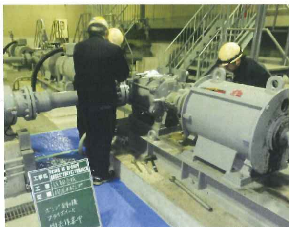
ポンプ設備の分解点検状況
