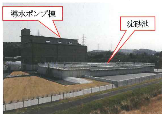
耐震補強工事が完了した野代導水ポンプ所 (平成28年度完了)
