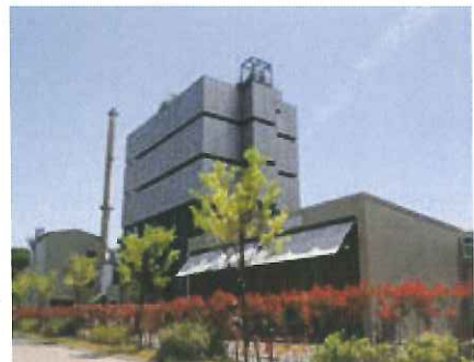
RDF焼却・発電施設
