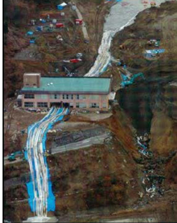
天然ダムポンプ排水
