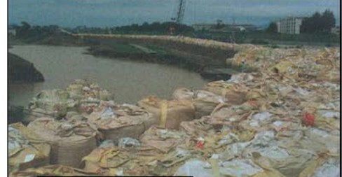
堤防決壊部応急仮締切
