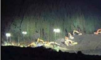
照明車による照明
