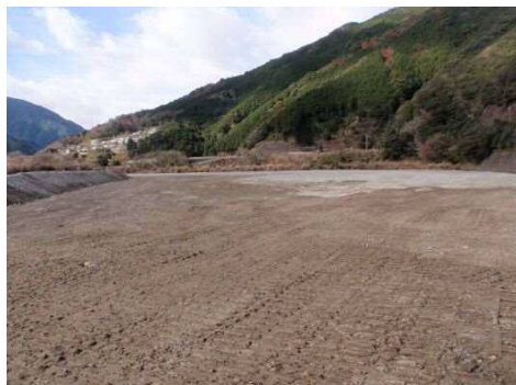
1号箇所(海山グラウンド付近)
