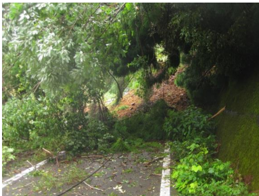
一般国道 169 号 被災状況
