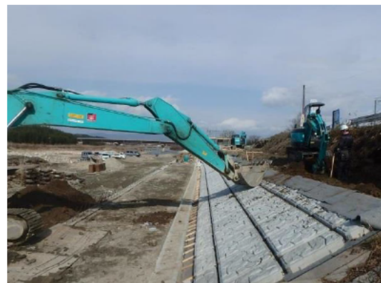
一級河川 木津川 (伊賀市)
