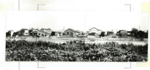
昭和51年台風17号 富洲原地区の床上浸水の様子
