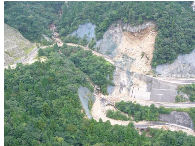
H20. 9. 2~3 国道477号 法面崩壊 (菟野町菟野)
