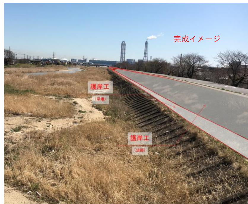
【余裕高部分の張りコンクリート】 (朝明川 川越町高松)
