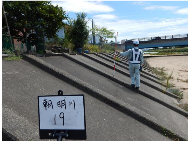
点検項目と緊急度ランク
