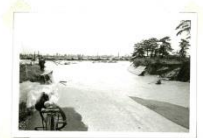
昭和51年台風17号 富洲原地区の床上浸水の様子
