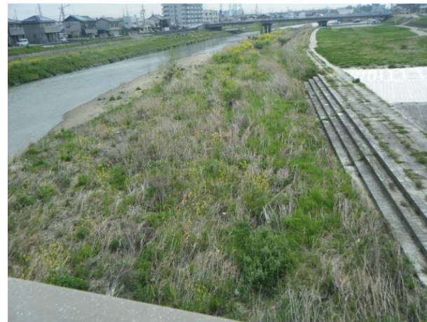
堆積土砂撤去（三滝川、四日市市北町）
