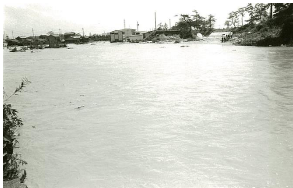
S49. 7. 25 天白川左岸決壊による浸水 (四日市市日永町)
