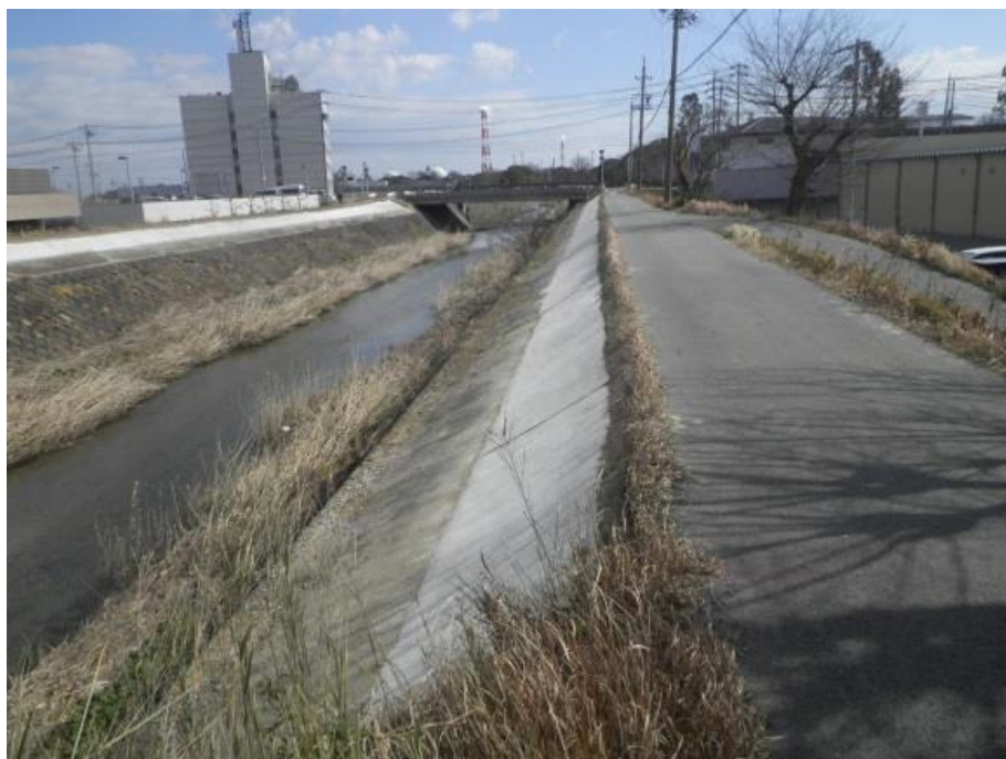
【余裕高部分の張りコンクリート】 (鹿化川 四日市市日永1丁目)
