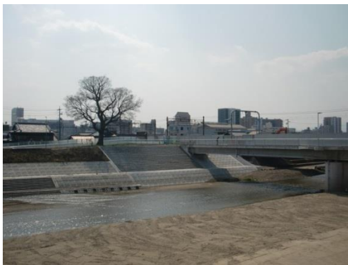
河川改修（橋梁改築、護岸整備） （三滝川 四日市市西町）
