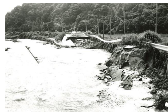
S49. 7. 25 朝明川右岸決壊 (四日市市萱生町)
