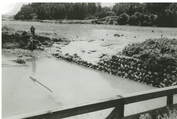
S46. 8. 30 足見川右岸決壊 (四日市市貝塚町)
