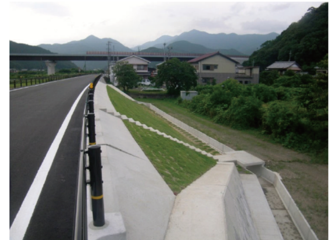
堤防補強工事の事例 (二級河川赤羽川)
