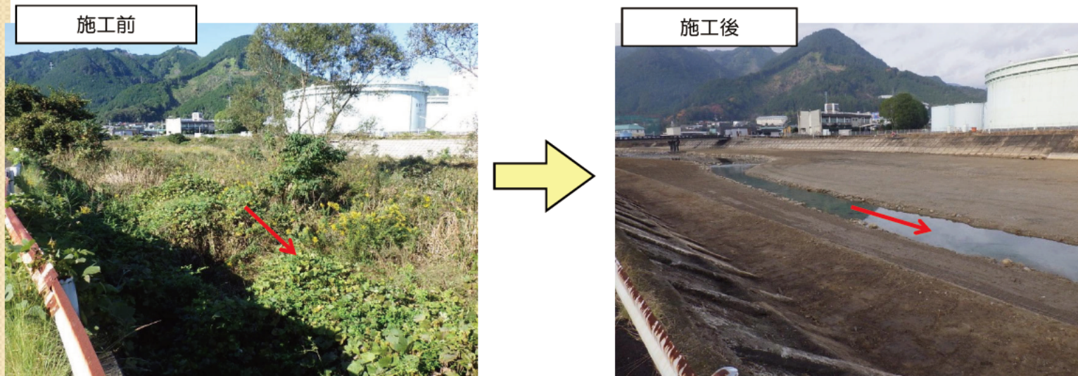
堆積土砂撤去の事例（二級河川矢ノ川）
