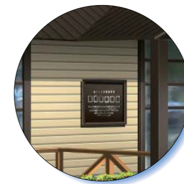
壁面広告 1階部分に設置し表示面積を小さくすることで、町並みに溶け込ませるよう配慮しています。
