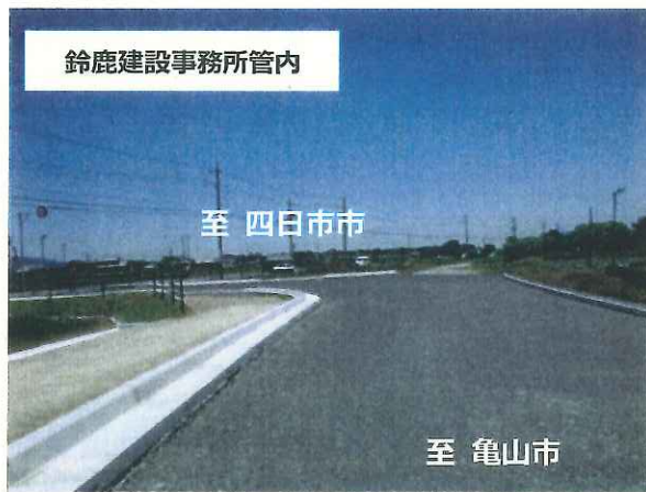
③国道 306 号(伊船バイパス)
