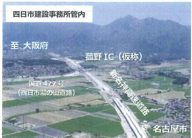
②新名神高速道路、国道 477 号(四日市湯の山道路)
