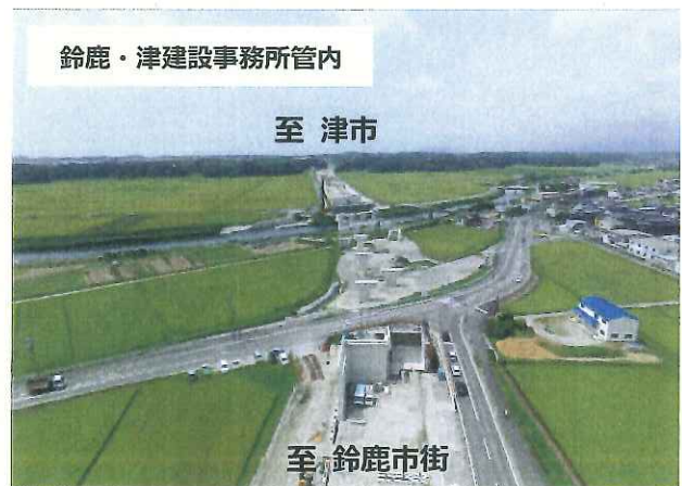
④国道 23 号(中勢バイパス)
