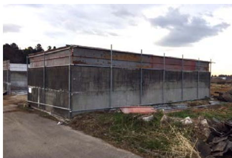
整備した堆肥舎
