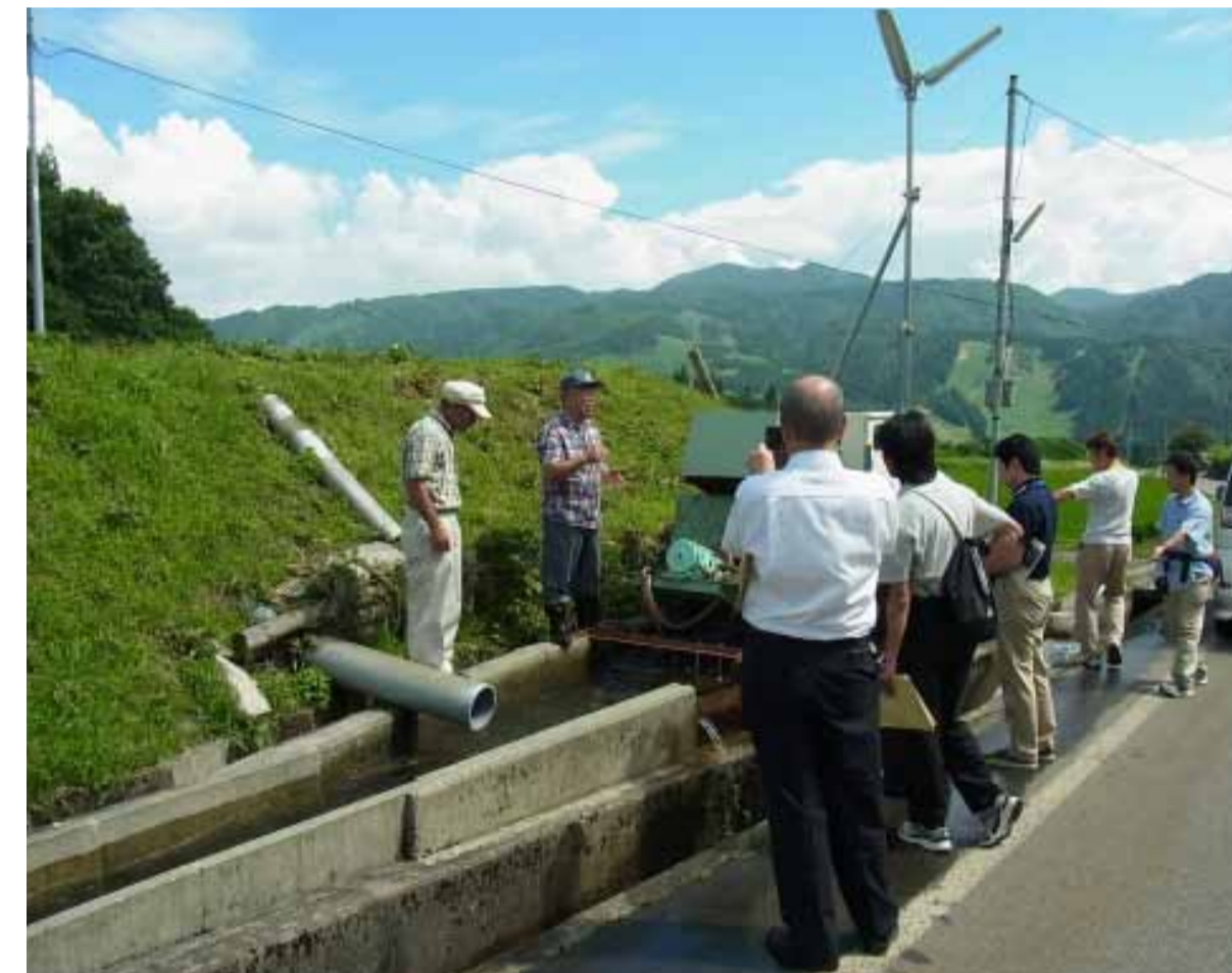
石徹白での視察（小水力発電の現場説明）
