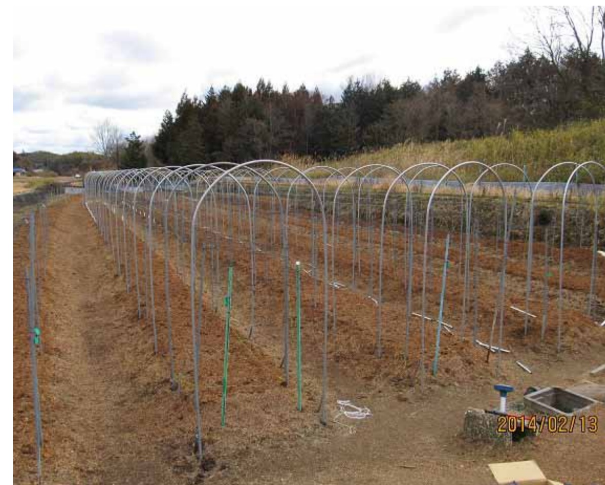
研修用ハウスの設置（設置途中）
