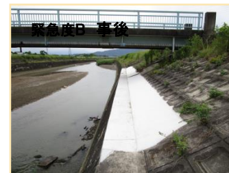
護岸ブロック沈下
