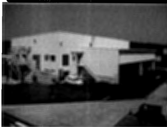
RDF 貯蔵施設
