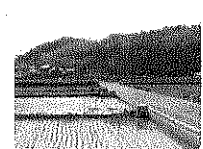
用水路のパイプライン化
