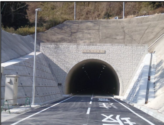
⑤ 三田坂トンネル坑口 (伊賀市三田地内)
