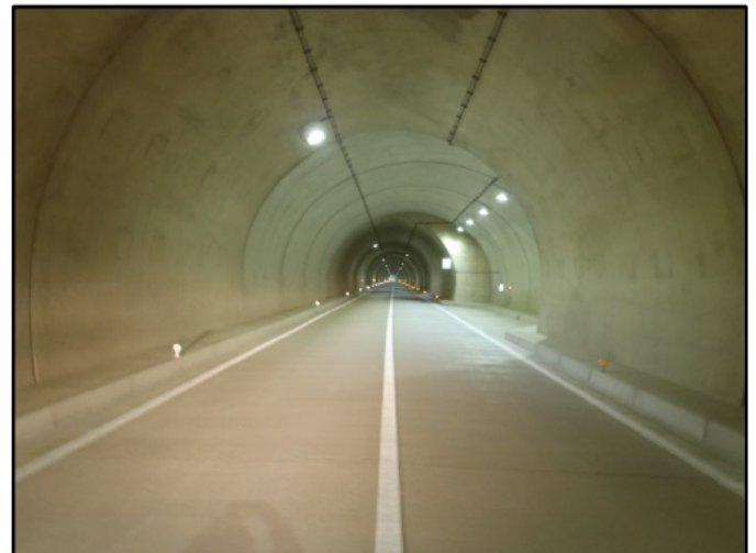
⑥ 三田坂トンネル (伊賀市諏訪から三田地内)
